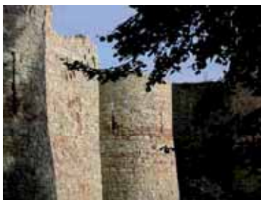
Enceinte de pierre du 13 e siècle, elle ceinture le donjon. Elle peut être observée à l'extérieur de la forteresse.
